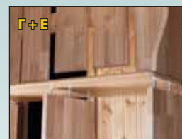
Г + Е Обе части соединяются эксцентриковыми стяжками
