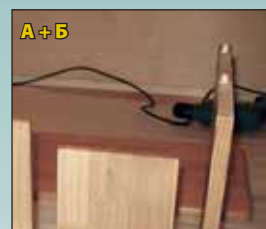
А + Б Козырек, соединение на шкантах
