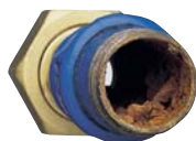
Ржавчина со стенок труб может попадать в водопроводную воду и засорять сантехнику
