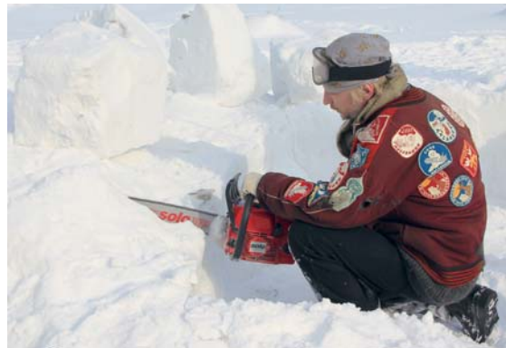
Бензопила — практически единственный вид моторной техники, используемый на стройке, с её помощью можно и дров заготовить, и напилить из слежавшегося снега блоки на скульптуры и облицовку Крепости. Заодно в процессе строительства удалось провести небольшую тест пилы Solo 643, предоставленной компанией «Идиама»
