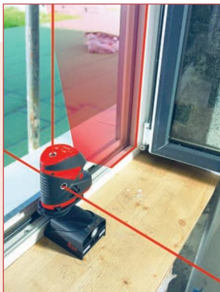
Проверка вертикальности установки оконной рамы
