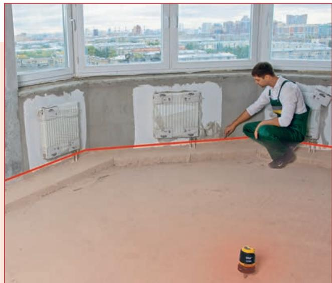
Задание горизонтальной плоскости проекционным нивелиром в помещении. Как правило, линия в таких условиях хорошо видна невооружённым глазом
