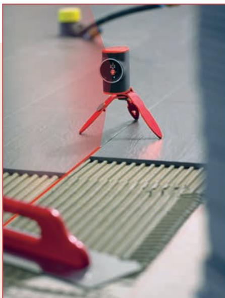
Определение направляющей линии для укладки кафельной плитки
