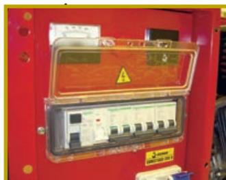
Устройства защитного отключения собраны в единый блок, закрывающийся откидной прозрачной защитной крышкой
