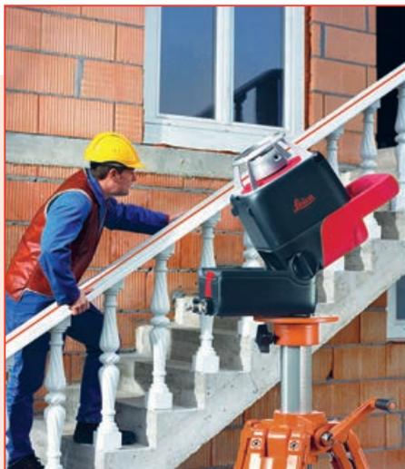
Построение наклонной плоскости с заданным уклоном с помощью ротационного нивелира
