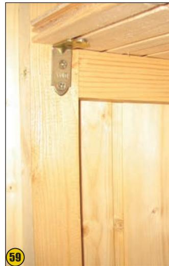
её вполне можно собрать из всё той же вагонки (57). В крайней дощечке необходимы вырезы под стойки (58). Для поддержки выступающей части можно прикрутить по уголку с каждой стороны (59).
