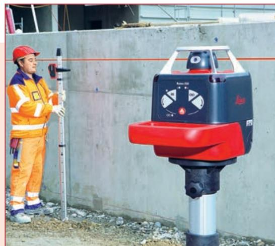
Задание горизонтальной плоскости ротационным нивелиром на открытой площадке. Разглядеть отметку глазами в таких условиях сложно, рабочий пользуется приёмником лазерного излучения
