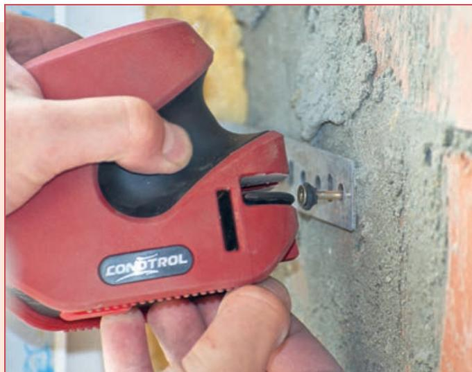
Ещё один пример монтажа — на вбитый в нужное место гвоздь (шуруп, дюбель)
