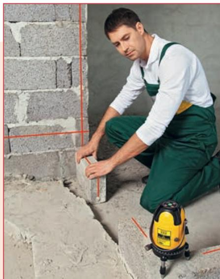
Построение осевых линий двух перпендикулярных стен
