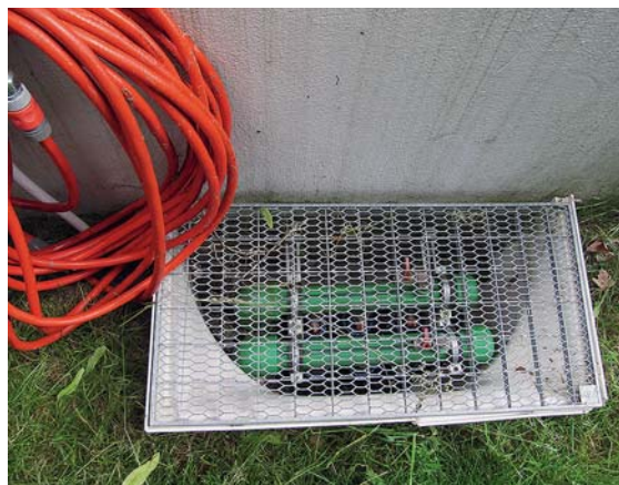
Три погружённых в землю грунтовых зонда снабжают энергией геотермальный насос Vaillant geOTHERMDrei
