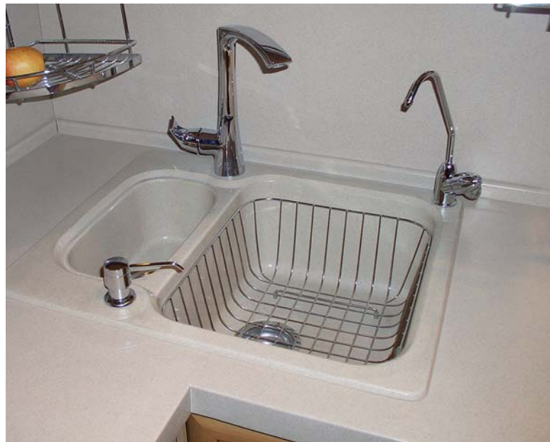
Полторачашная мойка Polygran F-09 из искусственного камня. Вмонтированы смеситель, кран для питьевой воды и дозатор мощного средства, в большой чаше — корзина для посуды
