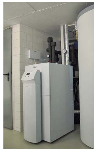
Три погружённых в землю грунтовых зонда снабжают энергией геотермальный насос Vaillant geOTHERMDrei
