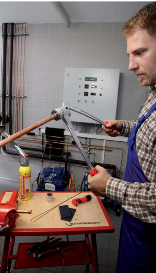
Монтаж медных труб с помощью инструмента Rothenberger
