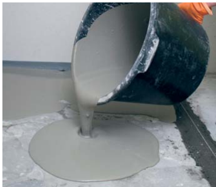
Приготовленную порцию выливают на пол
