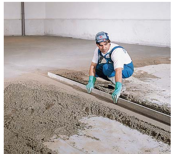
Выверка горизонтальности по «маякам». Фото: Mapei
