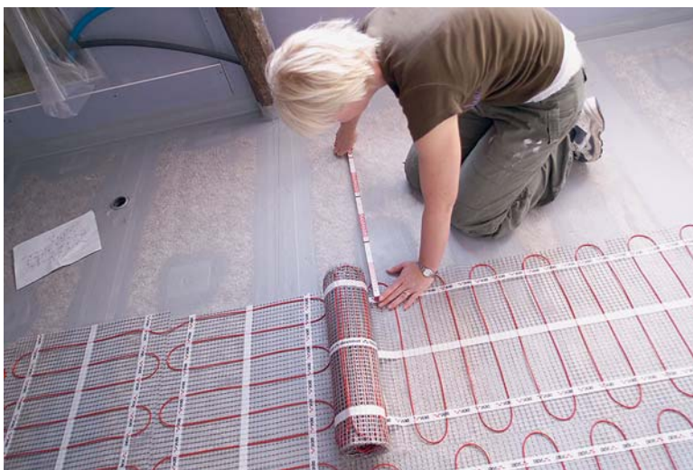
Монтаж нагревательного мата Devi
