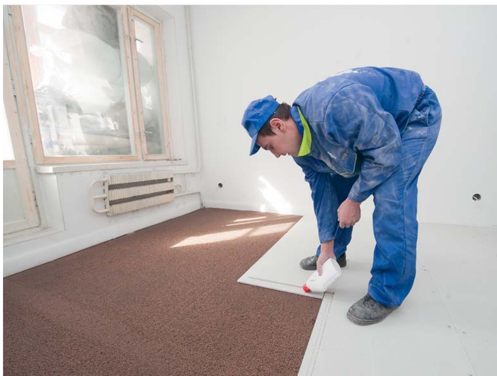
Монтаж сухой стяжки. Нижний слой — прокалённый мелкофракционный керамзит (обеспечивает максимальное заполнение всех дефектов основания, а также улучшает тепло- и звукоизоляционные свойства пола). Верхний слой — гипсоволокновые панели. Фото: Knauf
