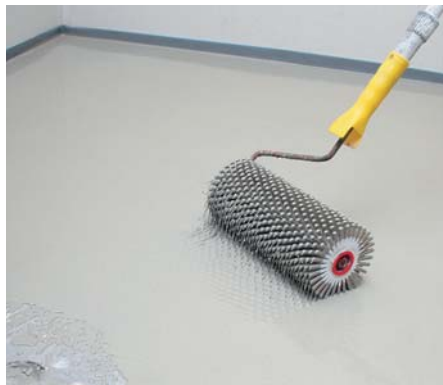
Прокатывание специальным «игольчатым» валиком помогает раствору равномерно распределиться по площади, а также удаляет воздух, попавший в раствор
