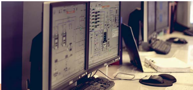
Автоматизированный терминал управления производством «Метадинеа»
