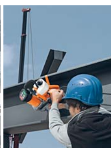
Машина предназначена для сверления отверстий в крупных металлических деталях, закрепляется с помощью магнита прямо на них. При вертикальном сверлении достаточно встроенного магнита, в других случаях следует использовать дополнительный страховочный ремень
