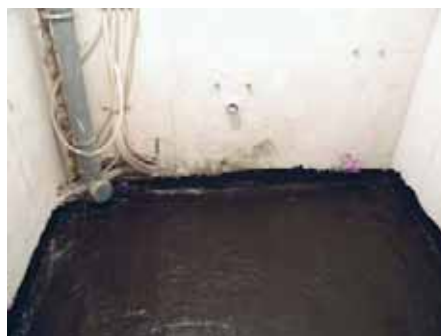
Возможно нанесение мастики щёткой. Мастика должна сохнуть не менее 2 часов
