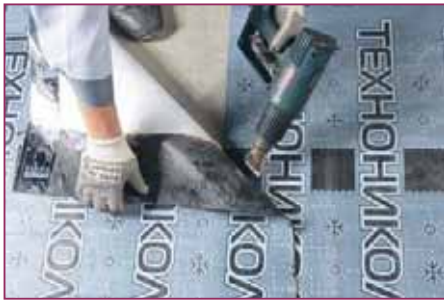
Нахлесты сваривают при помощи промышленного фена
