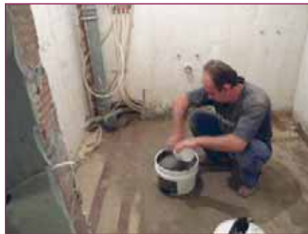
При необходимости добавляют активатор
