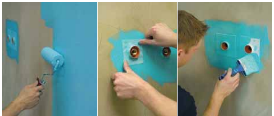
Мастику на стены наносят валиком. Места выхода труб укрепляют гидроизоляционной лентой и наносят слой мастики. Фото: Kiilto
