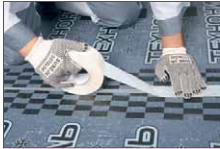
Продольные швы, поперечные нахлесты, места прохода труб отопления, а также перехлест материала в углу помещения проклеивают липкой лентой шириной не менее 5 мм
