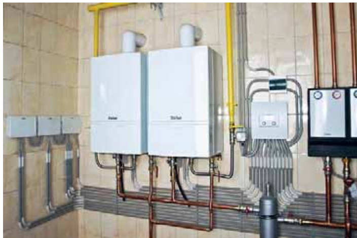
«Центр управления» всей системой — погодозависимый регулятор Vaillant calorMATIC 630/2, левее установлены котлы, ещё левее — модули Vaillant VR 60
