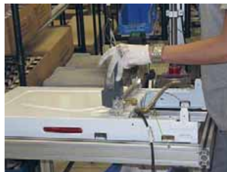
3. Монтаж крепления камеры сгорания
