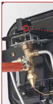
Газовый клапан с механизмом (рукояткой) управления. Снизу к клапану подходит провод от термопары, механизм пьезорозжига (провод в чёрной изоляции) смонтирован на этом же узле
