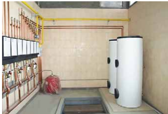
Расширительный бак, накопительные водонагреватели и люк в подвал. Окна в котельной (всего их два, одно — над входной дверью) нужны не только для освещения: это одно из требований нормативных документов
