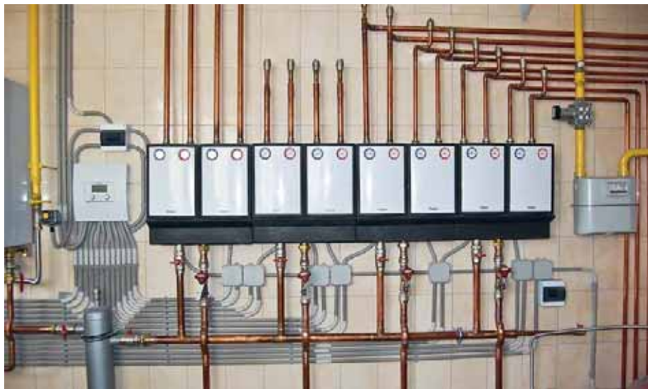
Насосные группы. Справа от них — газовый счётчик, слева мы снова видим регулятор Vaillant calorMATIC 630/2, а под ним — гидравлический разделитель
