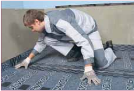
Продольные швы, поперечные нахлесты, места прохода труб отопления, а также перехлест материала в углу помещения проклеивают липкой лентой шириной не менее 5 мм
