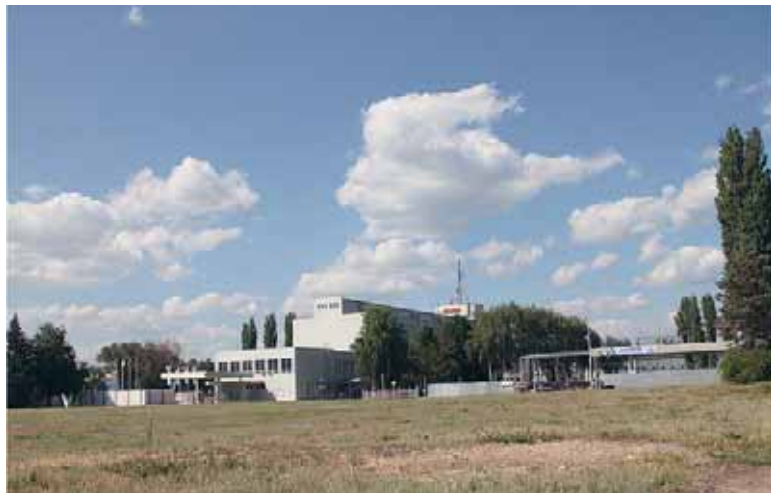
Производственная площадка Bosch в г. Энгельс
