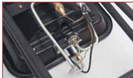
Газовые трубки от клапана идут к двум горелкам. Для розжига и контроля пламени используется запальная горелка (она находится ближе к лицевой стороне). По второй трубке газ подаётся в камеру, где смешивается с воздухом и направляется внутрь корпуса, к пористой нагревательной пластине
