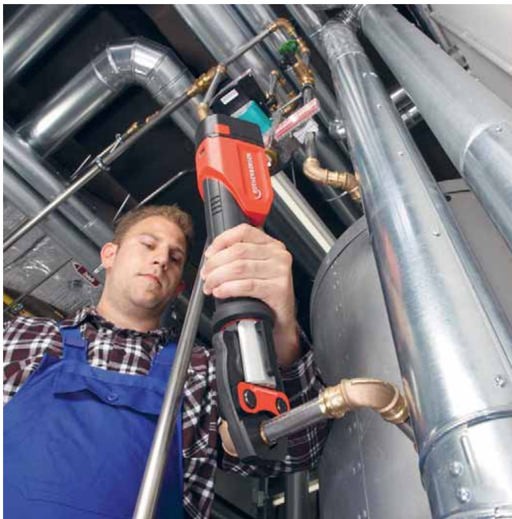
Конструкция многих моделей пресс-инструмента разработана таким образом, чтобы работать им было удобно даже одной рукой. Фото: Rothenberger
