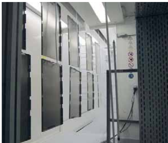
При запекании в термокамере порошок равномерно растекается с образованием гладкого покрытия
