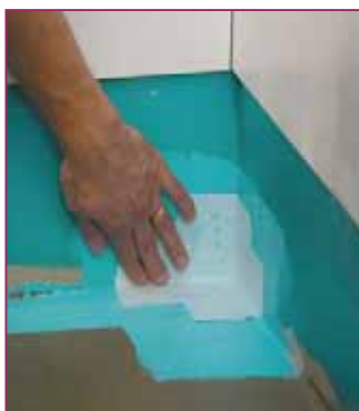
С помощью гидроизоляционной ленты тщательно проклеивают углы и места соединения стен и пола
