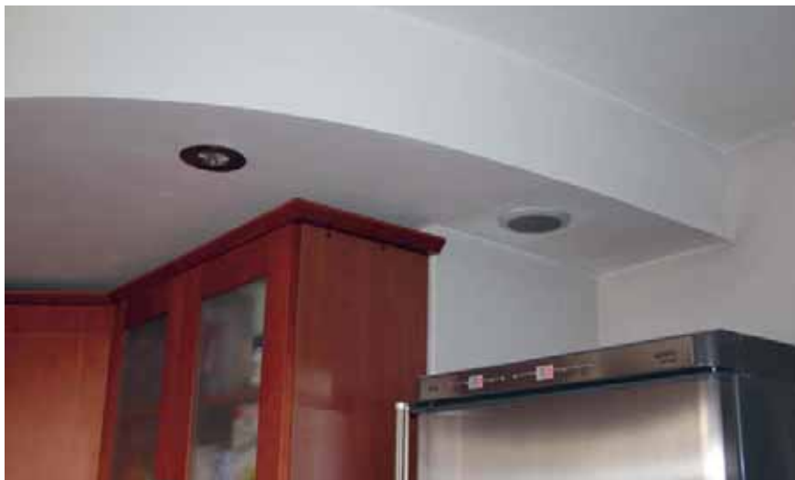
На фото за кухонным гарнитуром виден вентиляционный короб. У жильцов часто возникает желание его снести, чтобы расширить жилую площадь
