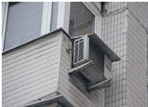
Производители рекомендуют устанавливать над наружным блоком козырёк — для защиты от воздействия прямых солнечных лучей и осадков
