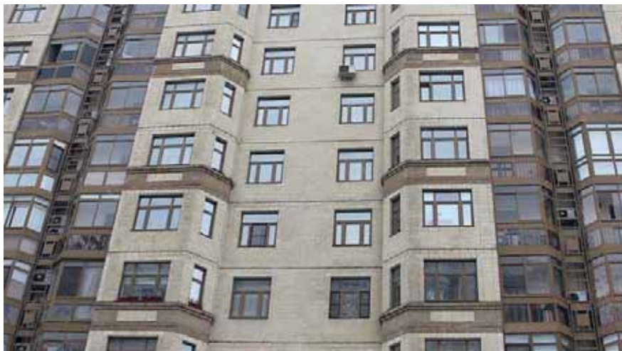
Некоторые застройщики предусматривают при проектировании дома специальные зоны для размещения наружного блока кондиционера
