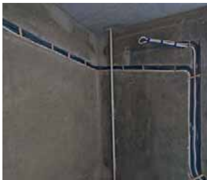
Не в каждой стене разрешено делать горизонтальные штробы для монтажа кондиционера, однако многие об этом не задумываются
