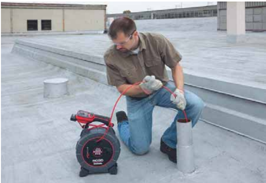
Проверка вентиляционного канала с помощью инспекционной камеры Ridgid
