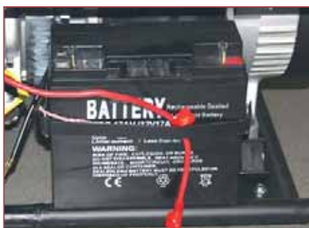
Необслуживаемая аккумуляторная батарея, закреплённая на раме. «Плюсовой» провод от неё идёт к электрическому стартеру двигателя, туда же подходят и провода от замка зажигания
