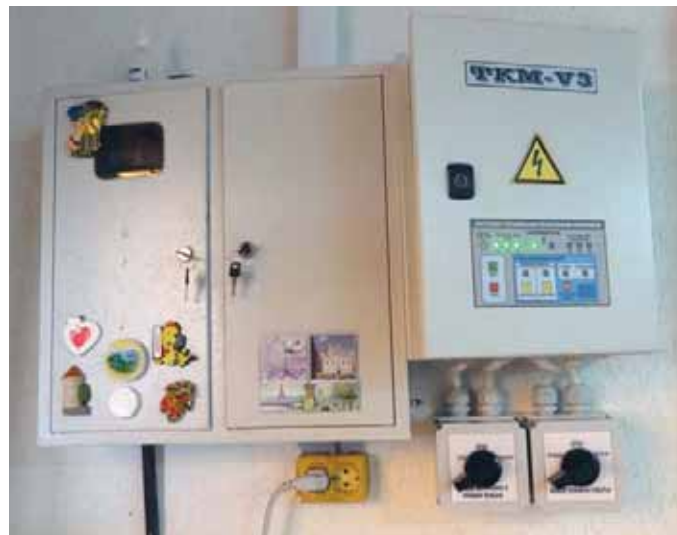
Блок автоматического ввода резерва, закреплённый на стене
