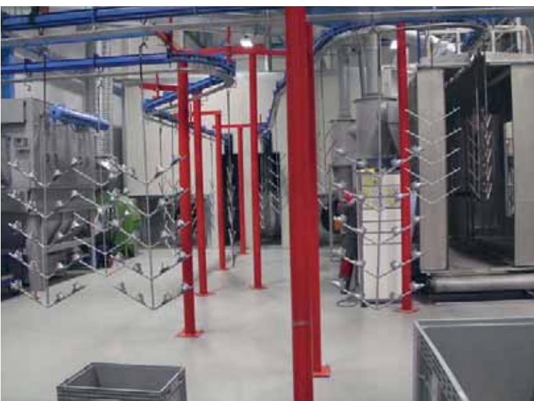
Автоматизированная линия по нанесению порошковой окраски в электростатическом поле
