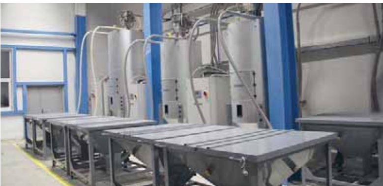
Система подачи полиамида для отливки пластиковых деталей
