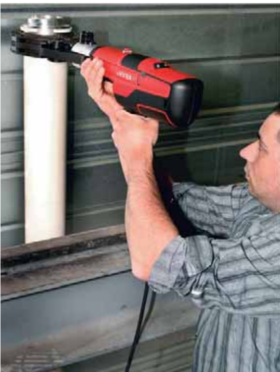
Трубы больших диаметров обжимают не обычными клещами, а с помощью специальных переходников. Фото: Virax
