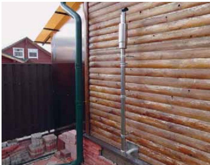
Пример системы газозудаления с дополнительным шумоглушителем, выведенной наружу
