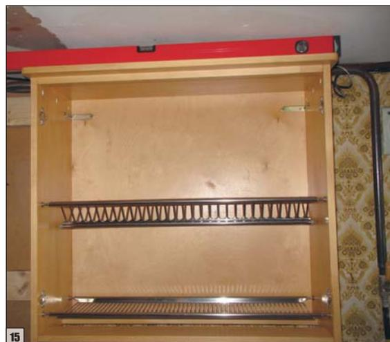
горизонтальные планки из мебельного щита. С одной стороны они крепятся к колонке, с другой — к стене и стойкам (16). Основная фурнитура — уголки (здесь не до эстетики, лишь бы закрепитесь).
