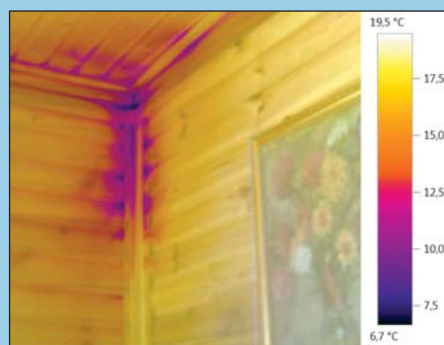
Вот так этот же угол выглядит на экране тепловизора. Холодный воздух поступает через дыру в обшивке на самом стыке стен и потолка, частично распространяется под внутренней обшивкой и выходит через щели ниже
