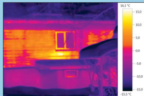
Тепловое изображение стены дома снаружи. Яркое пятно под окном — батарея. Очевидно, что теплоизоляция плохая практически на всей поверхности стены
