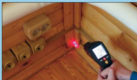
Ещё одна точка, где пирометр показал наличие серьёзных проблем. Второй этаж, а температура в нижнем углу отрицательная. При высокой влажности воздуха велика вероятность выпадения конденсата и ускоренного разрушения конструкции
