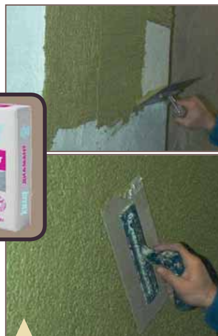
Нанесение минеральной структурной штукатурки «Кнауф Диамант»
