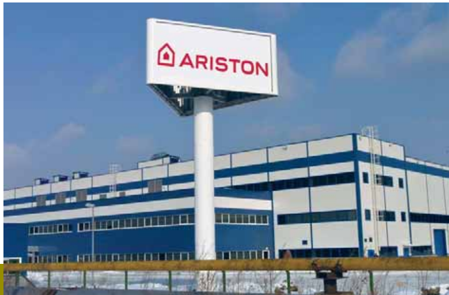
Завод Ariston Thermo Group во Всеволожске (Ленинградская область, Россия)
