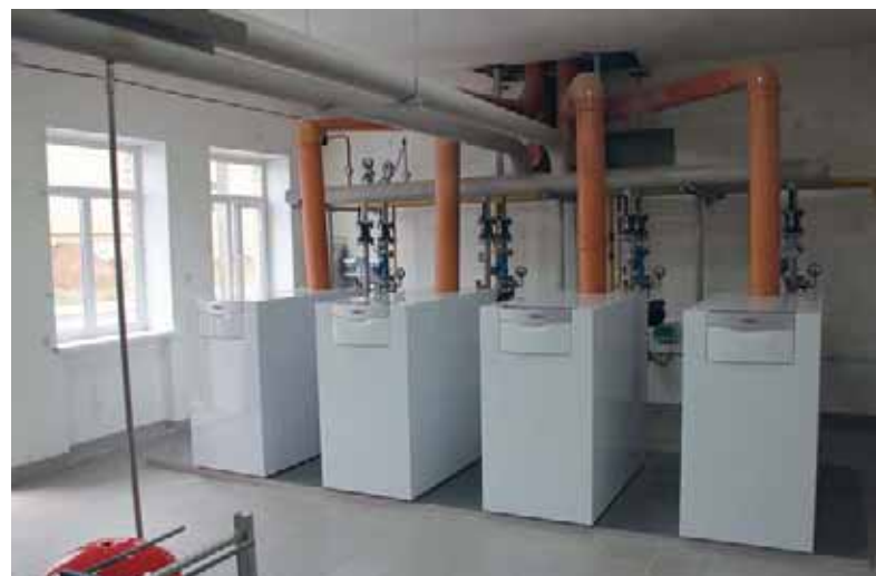
Система отопления здания цеха на базе газовых котлов Vaillant ecoCraft
