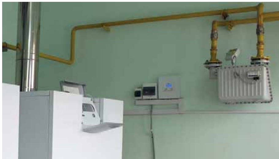
Настенный погодозависимый многофункциональный регулятор управления Vaillant calorMatic 630/3, установленный в котельной, отапливающей общежитие
