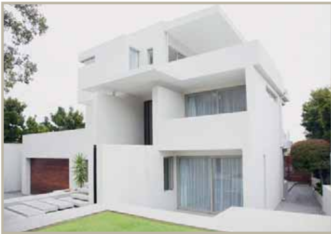
Дом из газобетонных блоков. Фото: Bonolit
