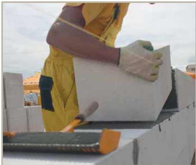
Укладка газобетонных блоков. Фото: Ytong
