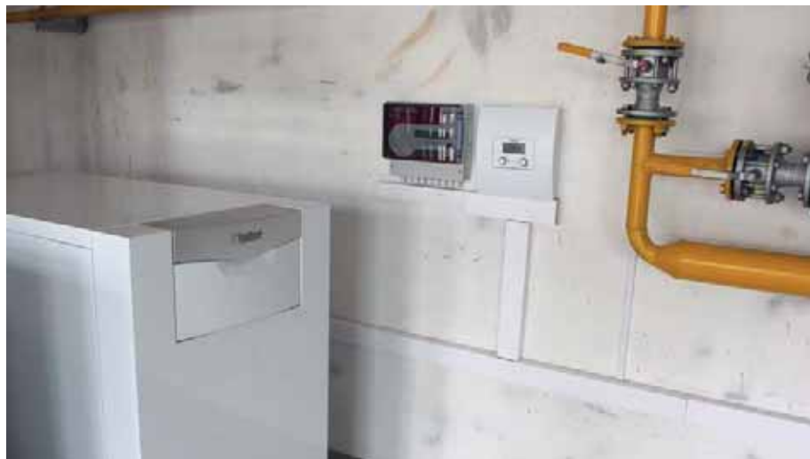
Автоматика Vaillant calorMatic 630/3, управляющая котельной, отапливающей цеха
