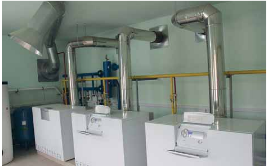
Система отопления здания общежития на базе газовых котлов Vaillant atmoCraft
