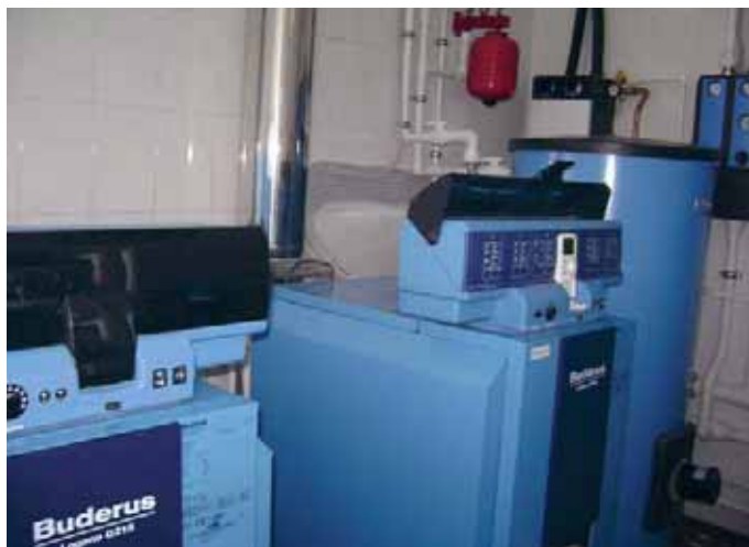
Отопительные котлы конструктивно одинаковы, различаются только контроллерами, установленными на их корпусе и, соответственно, функционалом: слева — «ведомый», справа — «ведущий»
