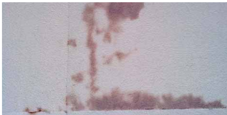
Так выглядят пятна на оштукатуренном фасаде
