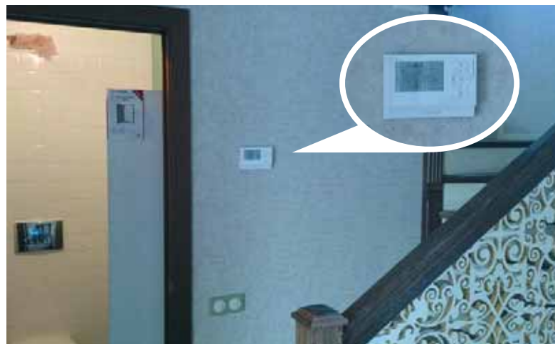
Терморегулятор Viessmann Vitotrol 200A, закреплённый рядом с «насосной»
