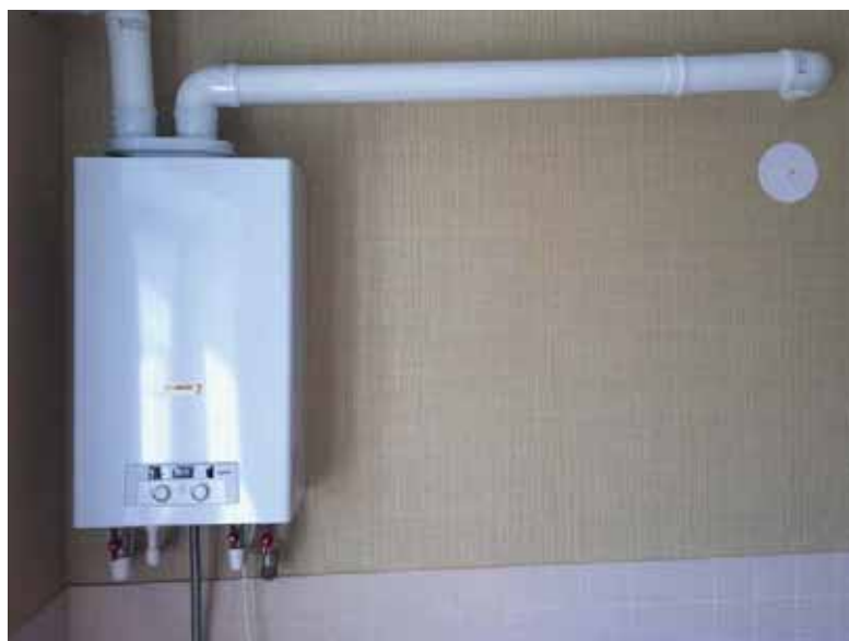
Газовый котёл Protherm «Рысь» НК 24. В доме реализовано раздельное подключение воздуховода и дымохода трубами диаметром 80 мм. Трубы дымоходов из котлов далее ведут в вертикальные дымоходы, смонтированные в капитальных стенах кухонь. Белый круг под местом ввода дымохода в стену — крышка для ревизии внутреннего дымохода
