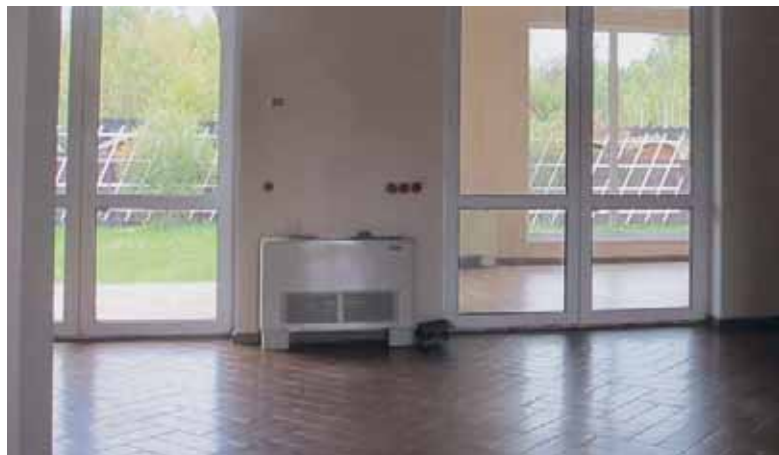
Фанкойл в кухне-столовой. Двери справа — вход в гостиную, за стеклом немного виден ещё один установленный в ней фанкойл
