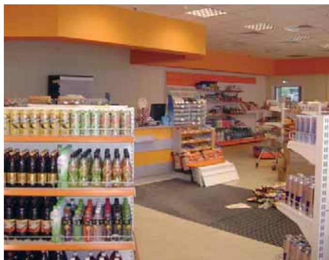
Торговый зал. На полу видна ниша в плитке, в которую уложено резиновое покрытие для сбора снега и мусора. Под этим покрытием находится один из контуров тёплого пола
