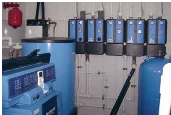
Цилиндрический бойлер косвенного нагрева находится рядом с котлом, за ним виден монтажный комплект (в белом корпусе), «ответственный» за работу геолоконтура. На стене установлены пять модулей отопительных контуров — по два на системы отопления и тепловые завесы и один на вентиляцию. Синий бак справа относится к системе водоподготовки
