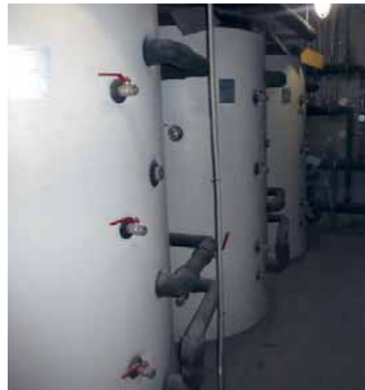
Накопительные баки особенно важны для поддержки системы в холодное время. При их использовании котлы можно топить реже, частота включения насосов тоже снижается
