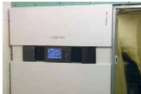
Подлестничная ниша перегородена корпусом теплового насоса и дверкой рядом с ним
