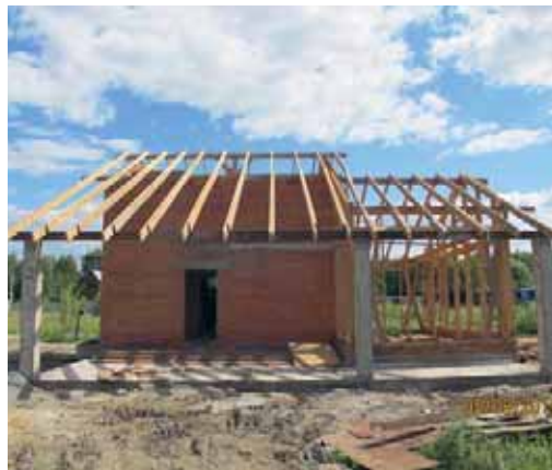
Начало строительства. Дом кирпичный, каркасная пристройка к нему — гостиная, свес крыши прикрывает будущую площадку для автомобилей, он поддерживается колоннами, установленными на монолитной плите
