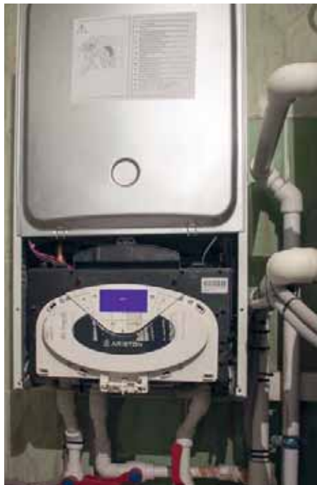
Газовый котёл Ariston Genius Premium Evo System 24FF — основной теплогенератор в системе. С одной оговоркой: он установлен «на вырост», дом ещё не газифицирован. Пока тепловую энергию дом получает от солнечных коллекторов и электрического котла, но перенастроить систему в дальнейшем несложно
