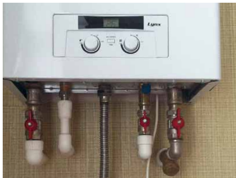
Котёл оснащён встроенной панелью управления с небольшим ЖК-дисплеем. Все подключения (кроме подачи и удаления воздуха) выполняются снизу: по краям — трубы системы отопления, ближе к центру — трубы ГВС, в центре — газовая труба
