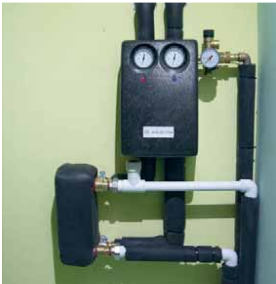
Насосная станция (двухтрубное исполнение) для перекачки теплоносителя гелиоконтуров и теплообменник, разделяющий «солнечный» контур и контур подачи собранного тепла в бойлер. Эта часть системы установлена в гараже
