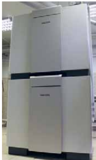
Особенность тепловых насосов Stiebel Eltron WPF 6 в том, что их можно ставить друг на друга. Это позволяет сэкономить место в котельной
