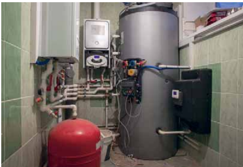
Котельная. Слева — электрический котёл и расширительный бак системы отопления. Справа — бойлер объёмом 600 л, поставляемый с насосным модулем и модулем ГВС. В середине — газовый котёл со снятой передней панелью
