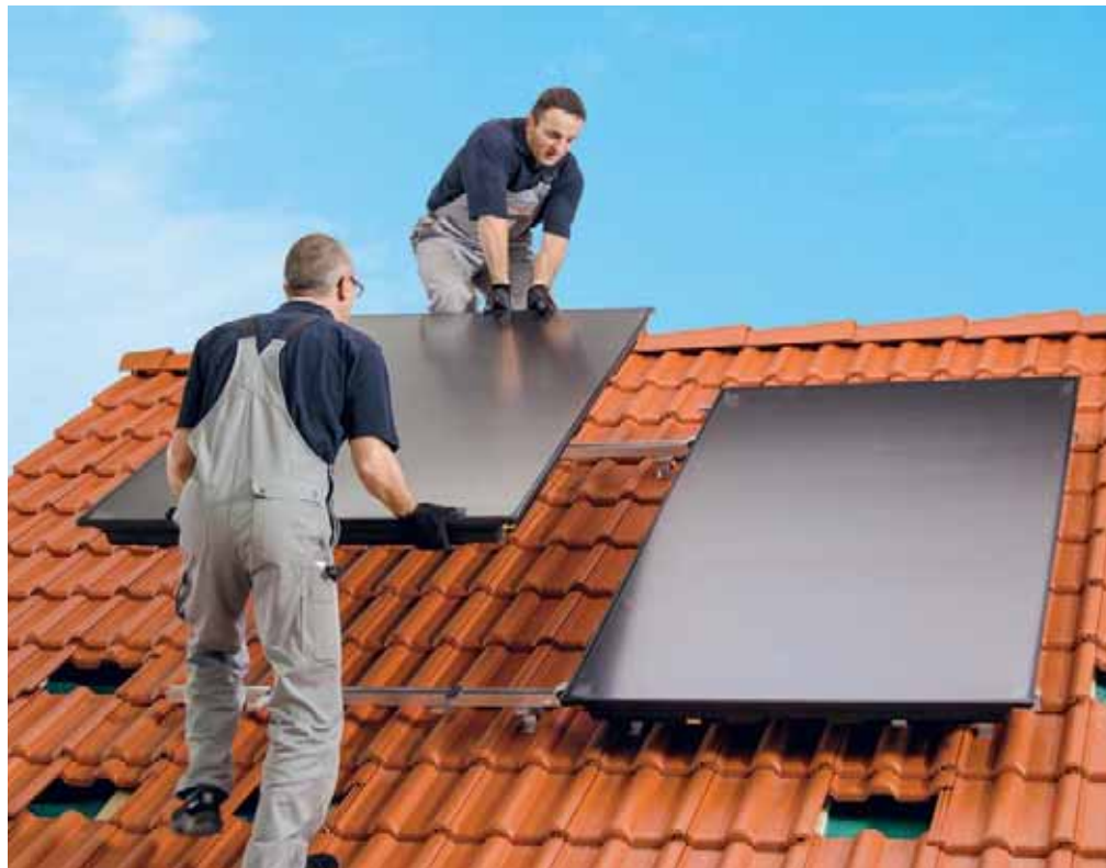
Пример установки коллектора на скатной кровле. Фото: Bosch
