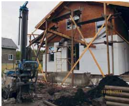
С помощью компактного бурового оборудования можно пробурить скважину для зонда или ХВС, не опасаясь сильно испортить окружающий ландшафт. Тут, впрочем, это неважно — скважины бурятся одновременно с обшивкой дома теплоизоляцией
