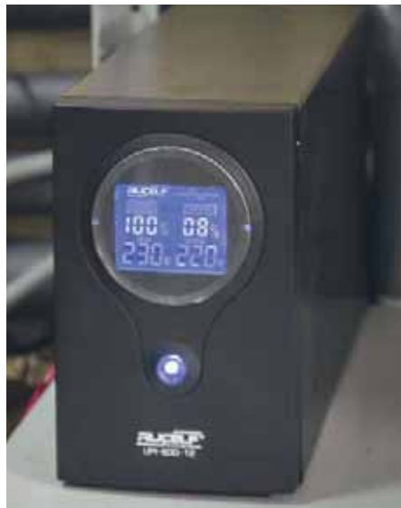
Ещё одно устройство «энергетической независимости», хотя и не относящееся напрямую к системам отопления и ГВС, — источник бесперебойного питания циркуляционных насосов и электроники управления
