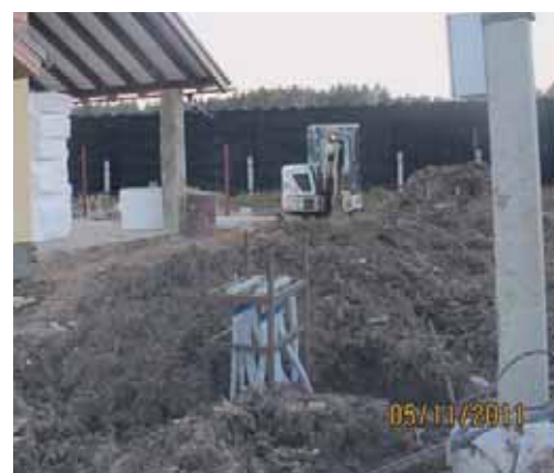
Зонды готовы: пробурены скважины, в каждую из них опущено по два витка труб, скважины заполнены цементно-песчаным раствором, а трубы (всего их 6, а значит, 12 выходов) подсоединены к распределителям рассола
