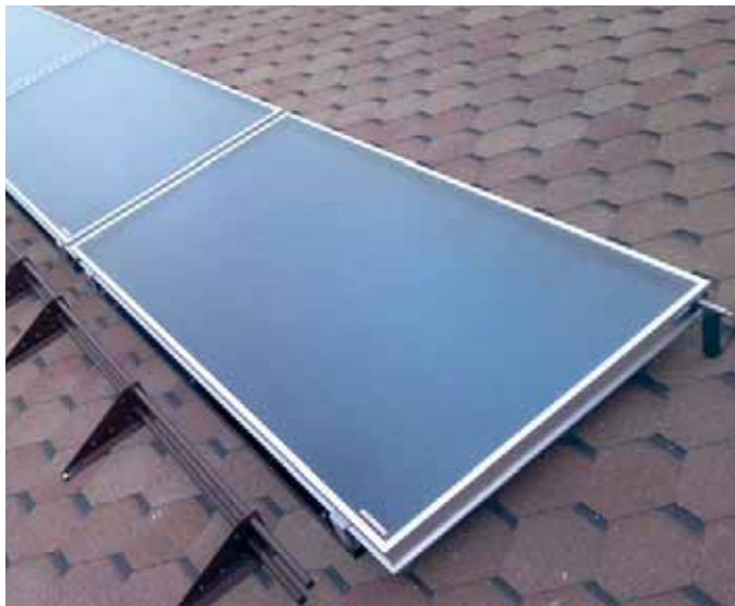
Солнечные коллекторы Stiebel Eltron SOL 27 Premium обеспечивают ГВС дома. Излишки тепла направляются на подогрев воды в бассейне
