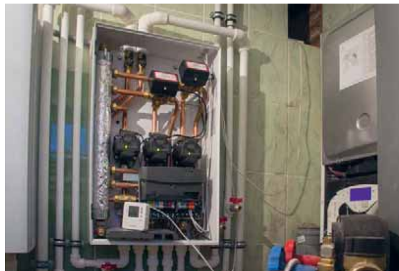
Распределение тепла по контурам отопления производится с помощью трёхзонального гидравлического модуля Ariston MMGM III Evo, который закреплён на стене котельной, между электрическим и газовым котлами
