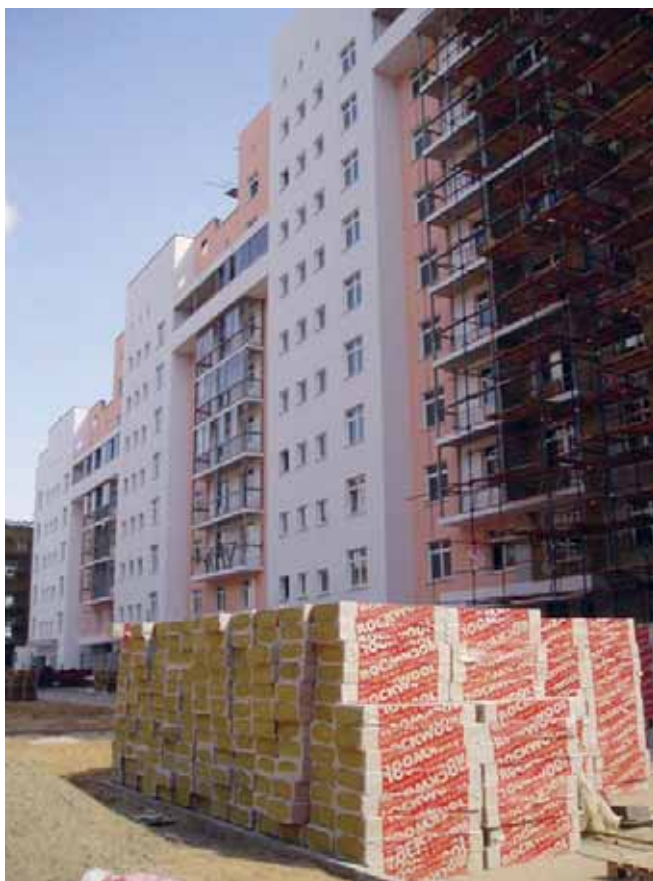
Утепление многоквартирного дома материалами Rockwool
