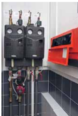
Тепловой пункт. Настенный контроллер Viessmann Vitotronic 200 НКЗВ, выполняющий роль «ведомого», и две насосные группы — на низко- и высокотемпературное отопление сауны
