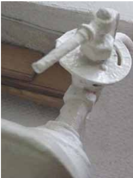
Действующий регулировочный кран 1911 года выпуска на ещё более старом чугунном радиаторе
