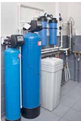
Система водоподготовки. Размещена у стены, напротив бойлера
