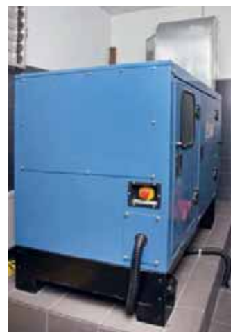
Дизель-генераторная установка с автоматическим включением также установлена в новом строении, в отдельном помещении
