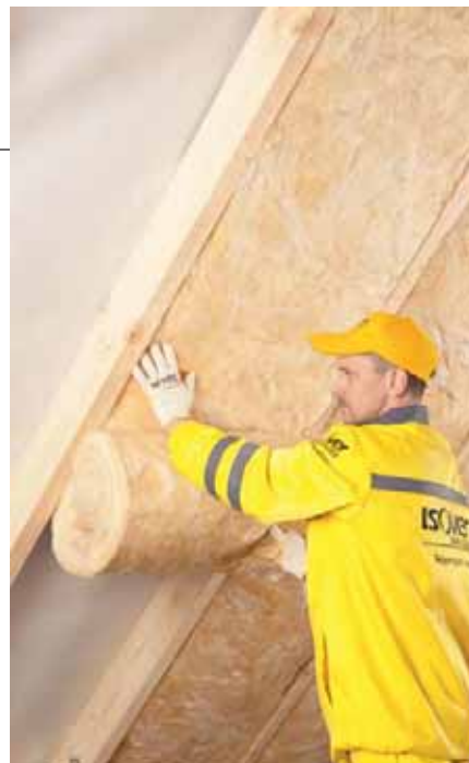
Упругий теплоизоляционный материал устанавливается в конструкцию без дополнительного крепежа. Фото: Isover
