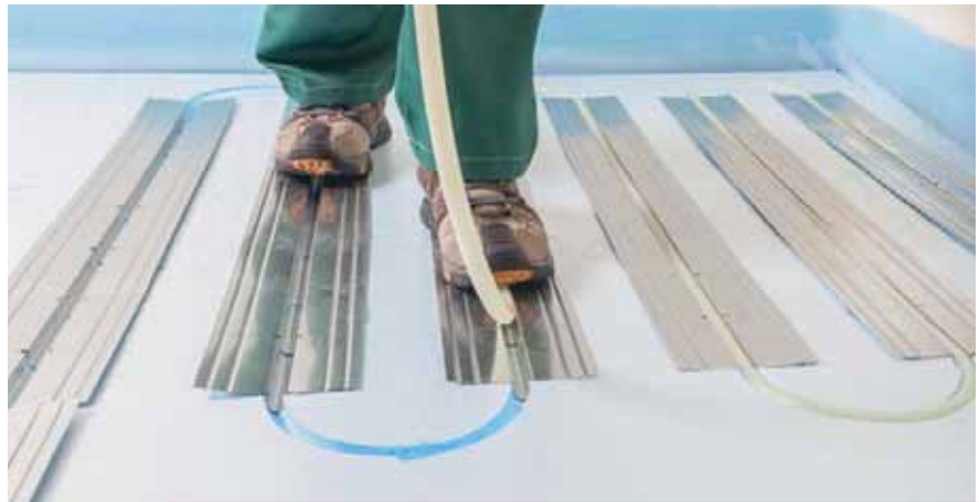
Сухой монтаж системы тёплого пола. В теплоизоляционной плите с помощью термоножа вырезаны желобки для укладки труб и металлических пластин. Фото: «ФорсТерм»
