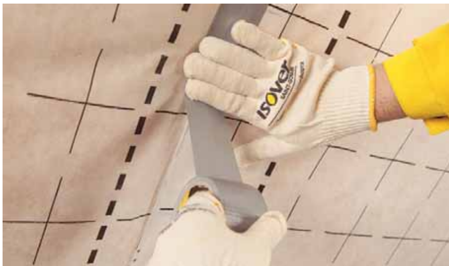
Стыки мембраны необходимо проклеить монтажной лентой или строительным скотчем. Фото: Isover
