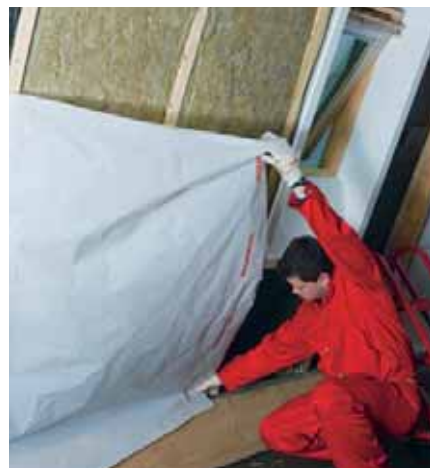
После монтажа теплоизоляции необходимо установить пароизоляционную мембрану. Фото: Rockwool
