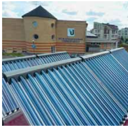
Вакуумные солнечные коллекторы на крыше ИТП в Заречье
