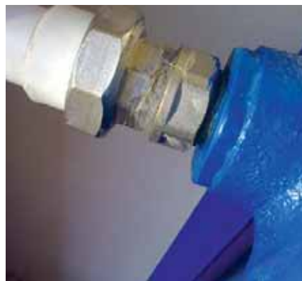
Деталь соединения чугунного радиатора с металлопластиковой трубой
