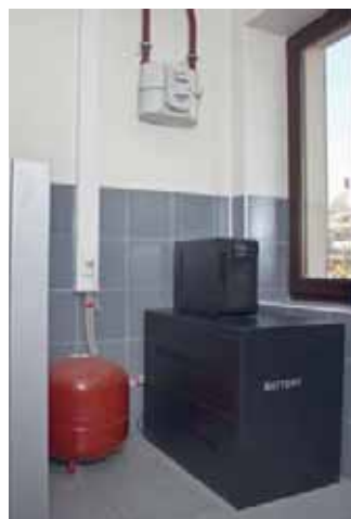
Рядом с котлом находятся блок с аккумуляторными батареями и источник бесперебойного питания; над ним, на стене, — газовый счётчик
